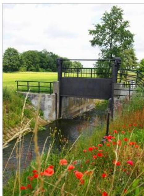
Jaz zastawkowy na Potoku Cisek (Jaborowice)
